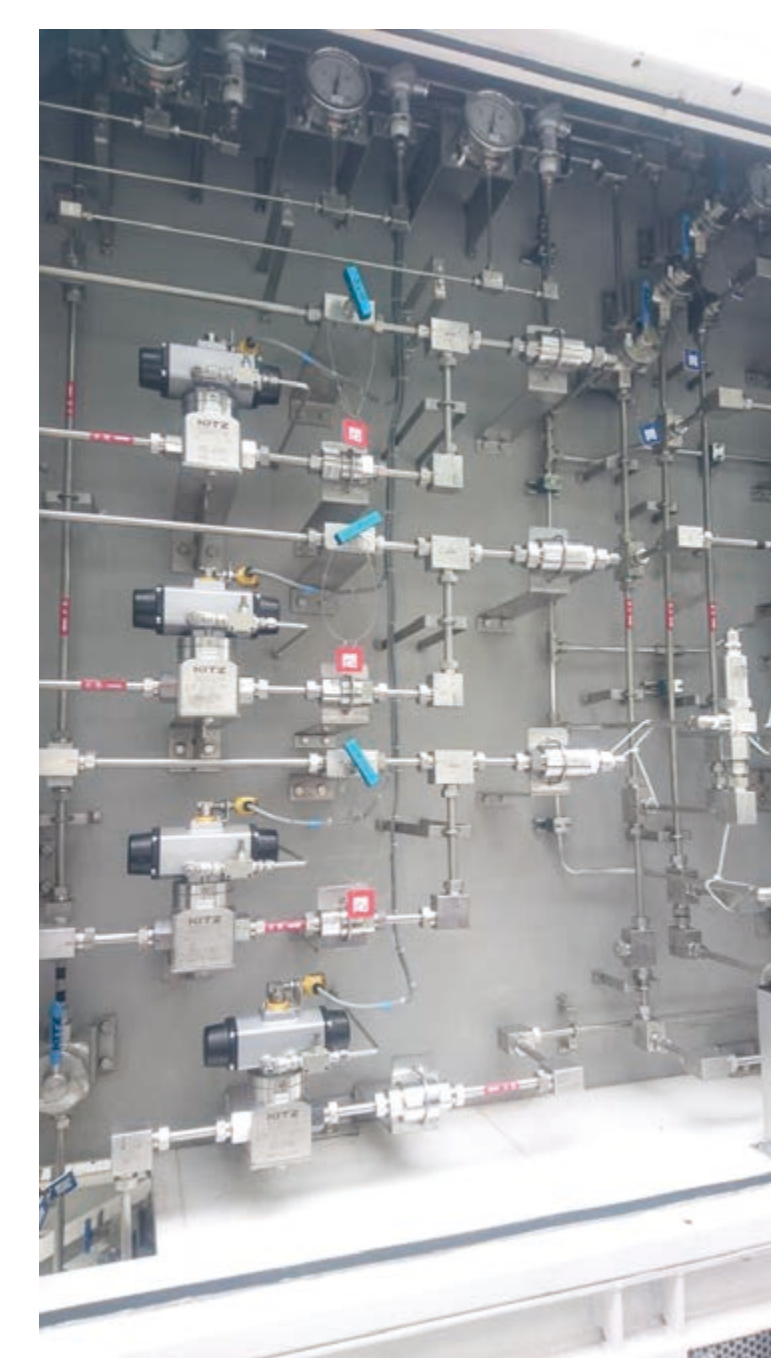
従来の配管例 ( (株) キッツ長坂工場水素ステーションより )
